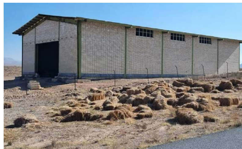
▲ ساخت سوله انبار ۷۰۰ متر مکعبی برای نگهداری علوفه آهوان منطقه حفاظت شده موته اصفهان
