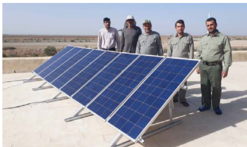
▲ نصب پنل خورشیدی ایستگاه دز در استان خوزستان با ظرفیت ۱۲۰۰ وات
